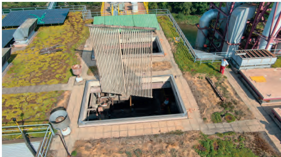
Austausch der Überhitzerregister (© Marc Deppeler)
