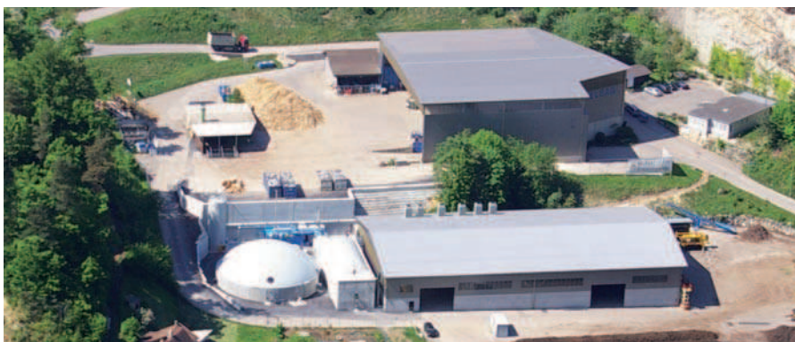
Biogasanlage Liesberg (CH)
