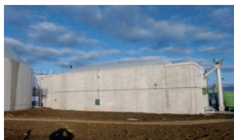
Pfropfenstrom-Fermenter aus Stahlbeton
