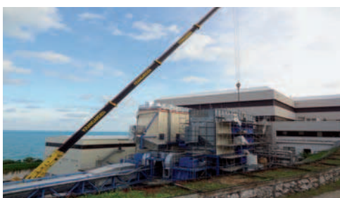
MPW Bermuda, Sanierung Linie 1 und 2
