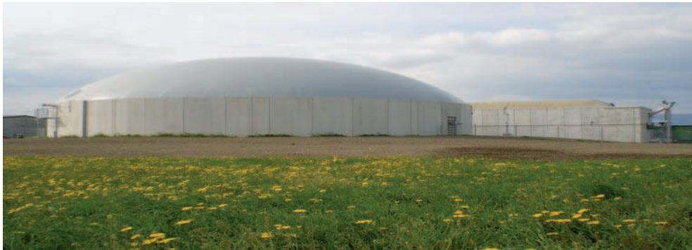
Biogasanlage mit Pfropfenstrom-Fermenter und abgedecktem Gärrestlager zur Nutzung des Restgaspotentials
