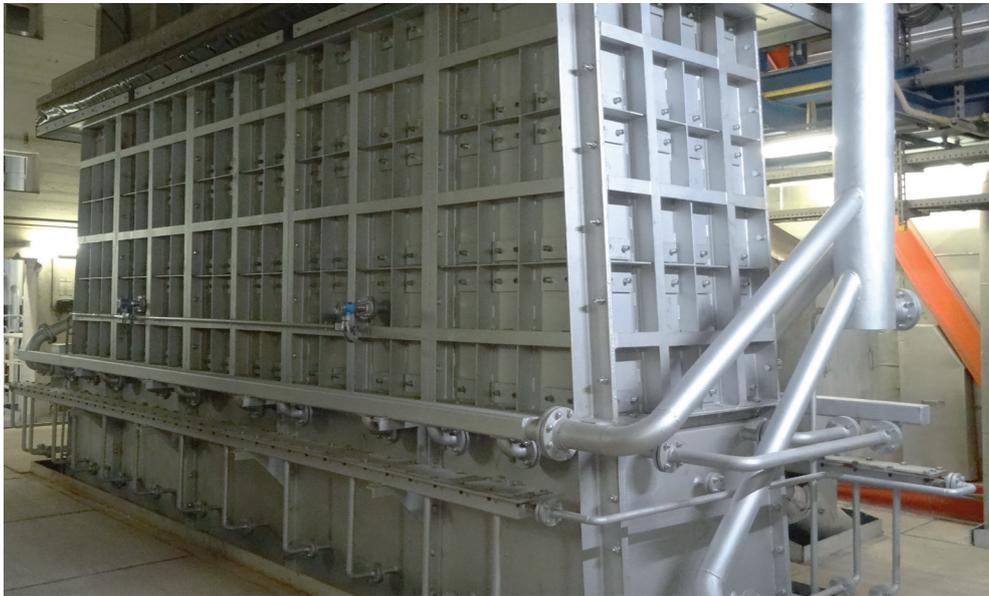
*Einfüllschacht mit Verdampfungskühler*
