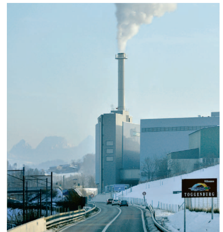
Neue Rauchgasreinigung ZAB
